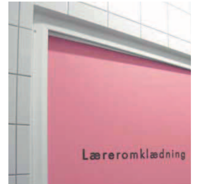
Türzargen aus Aluminium Wahlweise weiss oder farbig pulverbeschichtet oder matt eloxiert.
